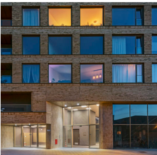
Bergingen zijn geclusterd in het gebouw en leveren geen dode gevels op.
