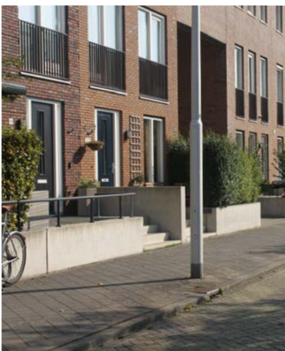
Het hoogteverschil bij een (half) verdiepte garage kan worden ingezet voor terrassen.
